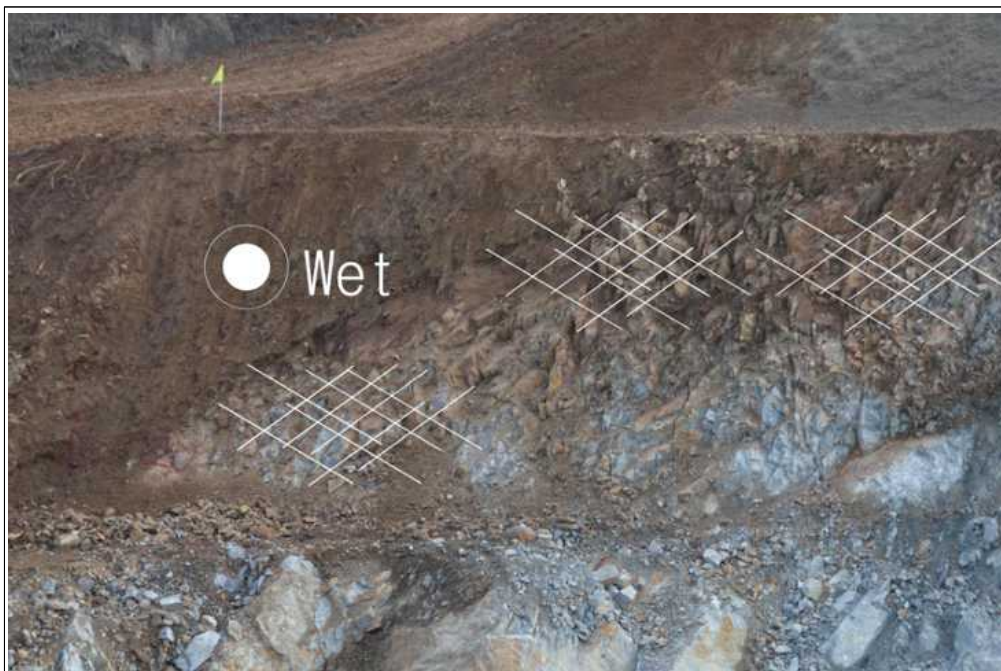
【그림 38】 D 영역 상세사진 (지하수 유출 및 세편화된 암석)
