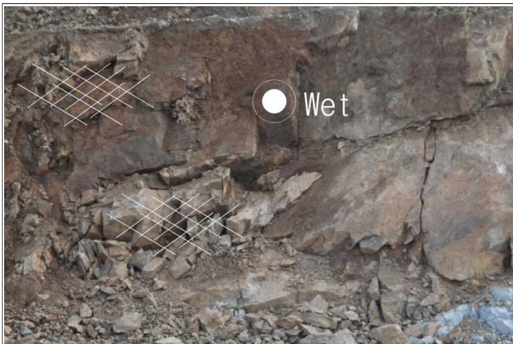
【그림 20】 A 영역 상세사진(지하수 유출 및 세편화된 암석)
