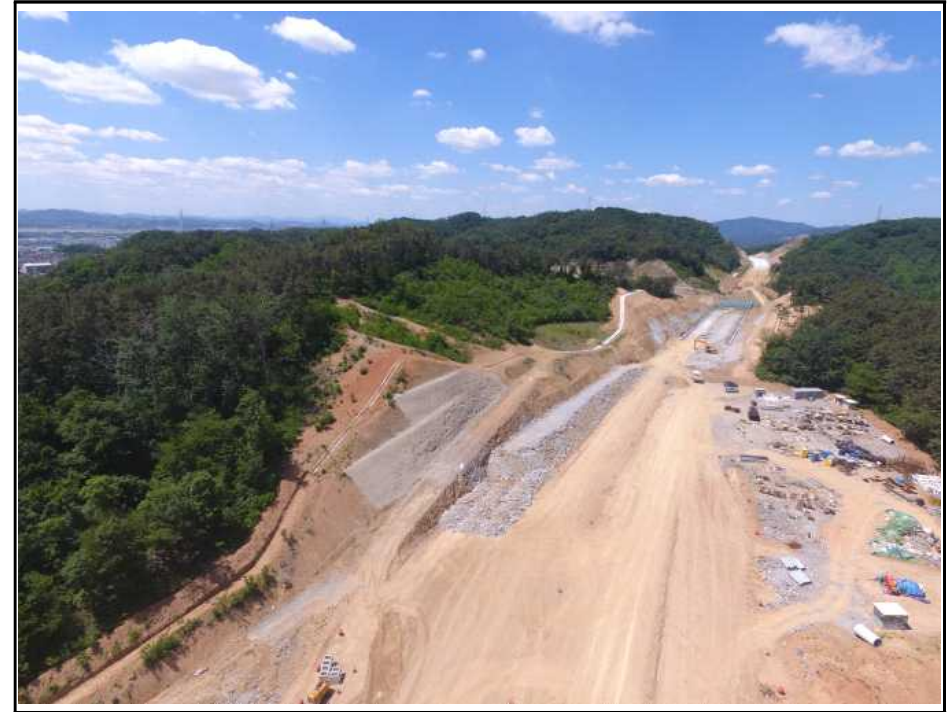
【그림 4】 깎기비탈면 종점부 측면 사진
