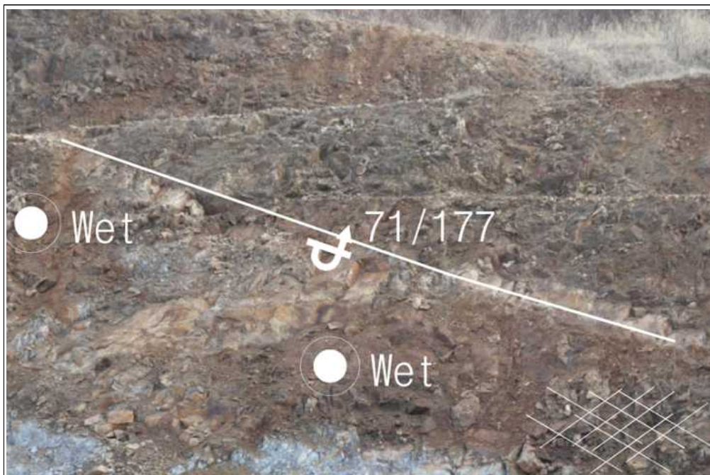
【그림 23】 B 영역에 발달한 불연속면(전도파괴 양상)
